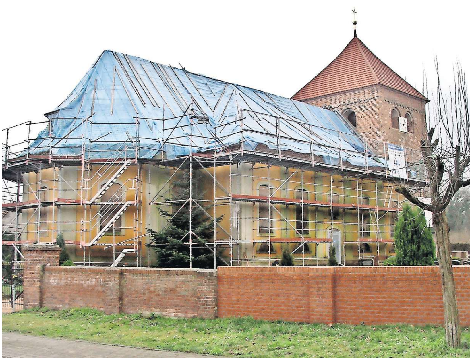
Derzeit wird die Kirche Hohennauen saniert. Demnächst könnte der 2. Bauabschnitt für 500 000 Euro starten
